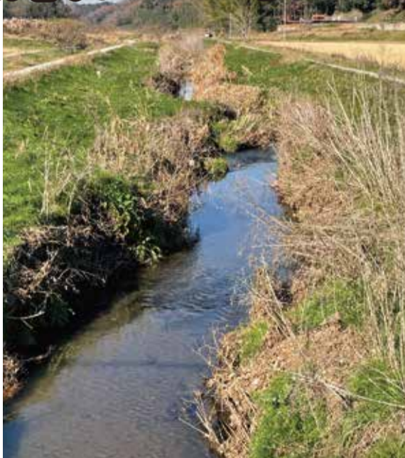
堆積土砂の浚渫が必要な根木名川
